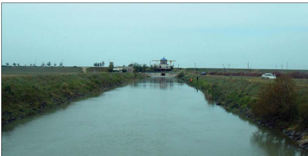
Рис. 13. Плотина Чограйского водохранилища в центральной части и начало Черноземельского канала.
