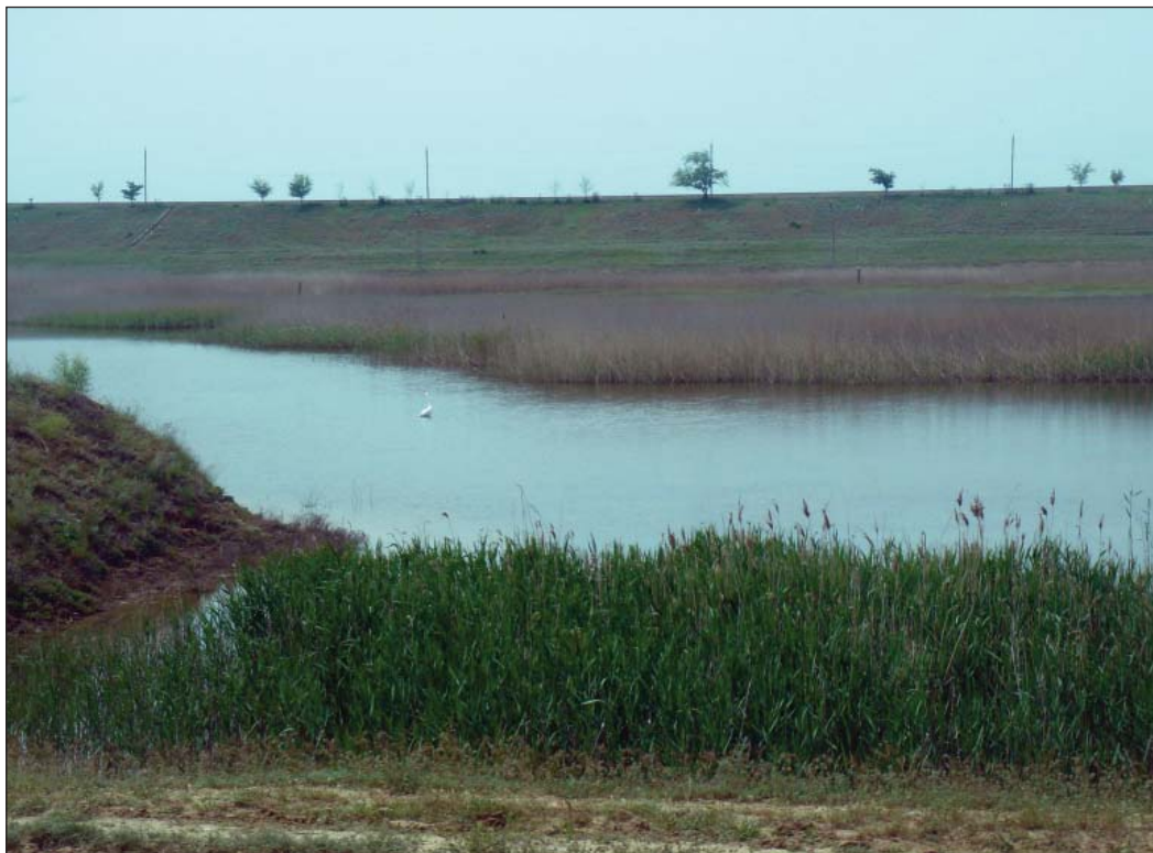
Рис. 14. Плотина Чограйского водохранилища в центральной части. Вид на запад. Современный исток Восточного Маньча.
